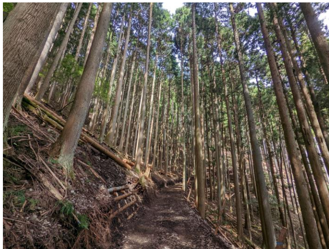
完成した作業道(小菅村)田元地区
